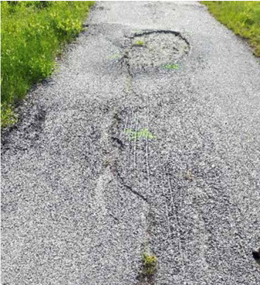
Kuva 19. Asfalttirataa Rajaseututaajamassa. (Kuva: Päivi Armila)
